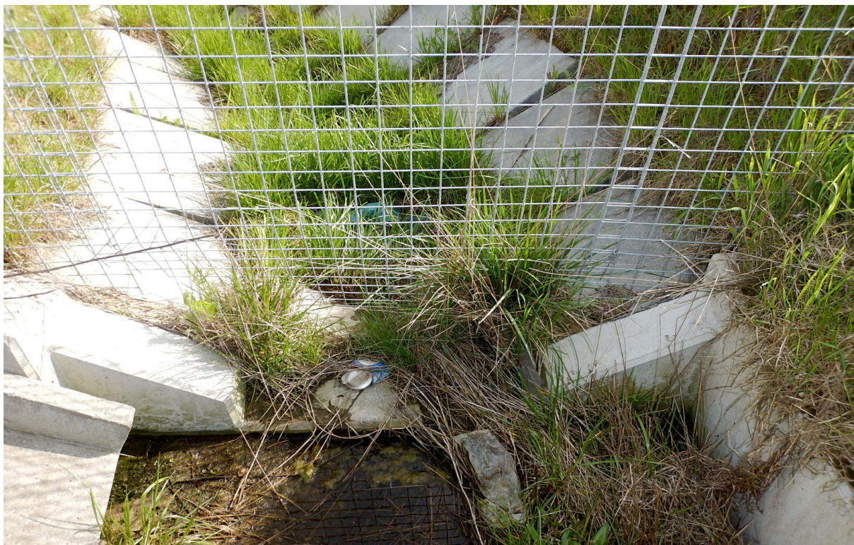
Fot. 20. Brak szczelnych zabezpieczeń w miejscach przekraczania rowów-siatki o dużych oczkach nie zatrzymują migrujących płazów
