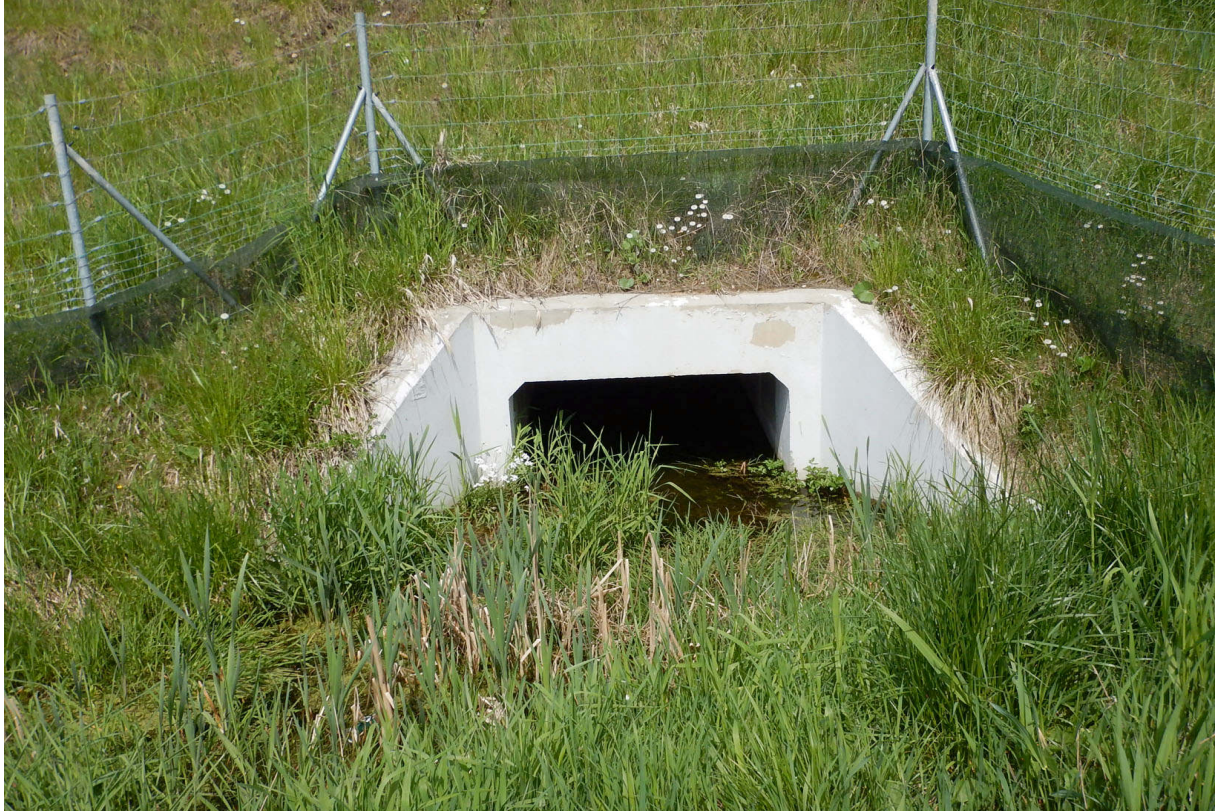
Fot. 18. Ogrodzenia dla małych zwierząt nie naprowadzają migrujących osobników do wylotów przejść
