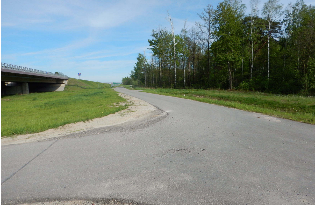
Fot. 2. Dolne przejście dla zwierząt k. miejscowości Jędrzejów Stary-strefy naprowadzania zwierząt przecina asfaltowa droga serwisowa, co ogranicza funkcjonalność obiektu
