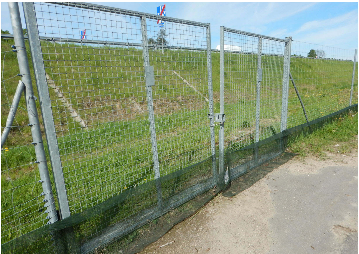
Fot. 15. Przy bramach i furtkach ogrodzenia z siatek polimerowych są nieszczelne-obecne są liczne luki i szczeliny umożliwiające swobodne wychodzenie płazów na jezdnie
