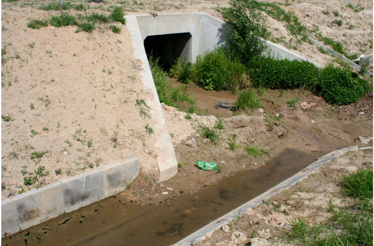
Fot. 26. Przy wybranych przepustach zastosowano betonowe ścianki naprowadzające płazy- niestety błędy projektowe i wykonawcze spowodowały ich całkowitą dysfunkcjonalność
