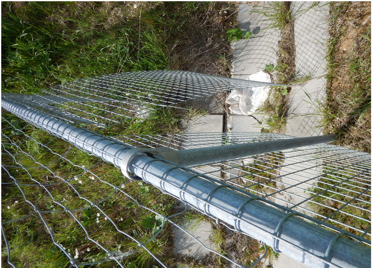
Fot. 19. Brak szczelnych zabezpieczeń w miejscach przekraczania rowów-istniejące luki umożliwiają swobodne przechodzenie nawet saren i dzików
