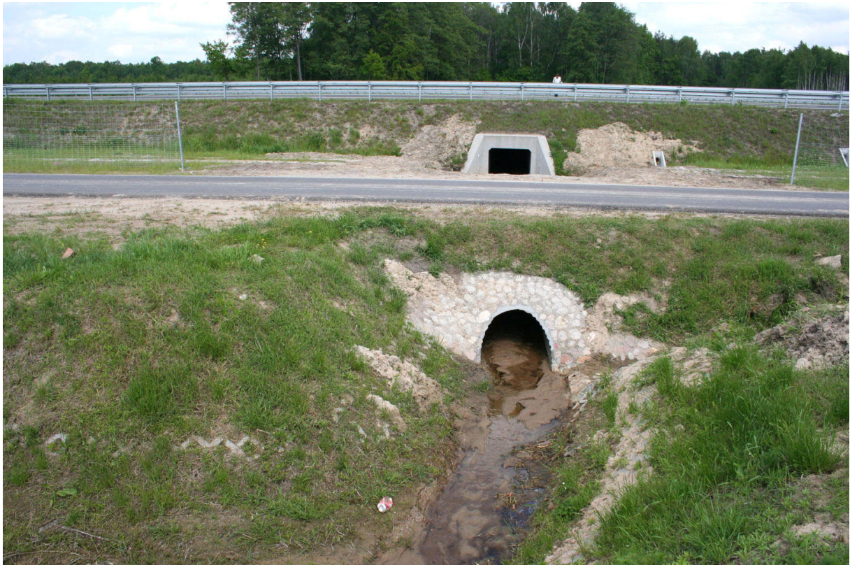
Fot. 30. Przepusty pod drogami serwisowymi nie zostały przystosowane do spełniania funkcji faunistycznych i nie są zsynchronizowane z przejściami pod autostradą
