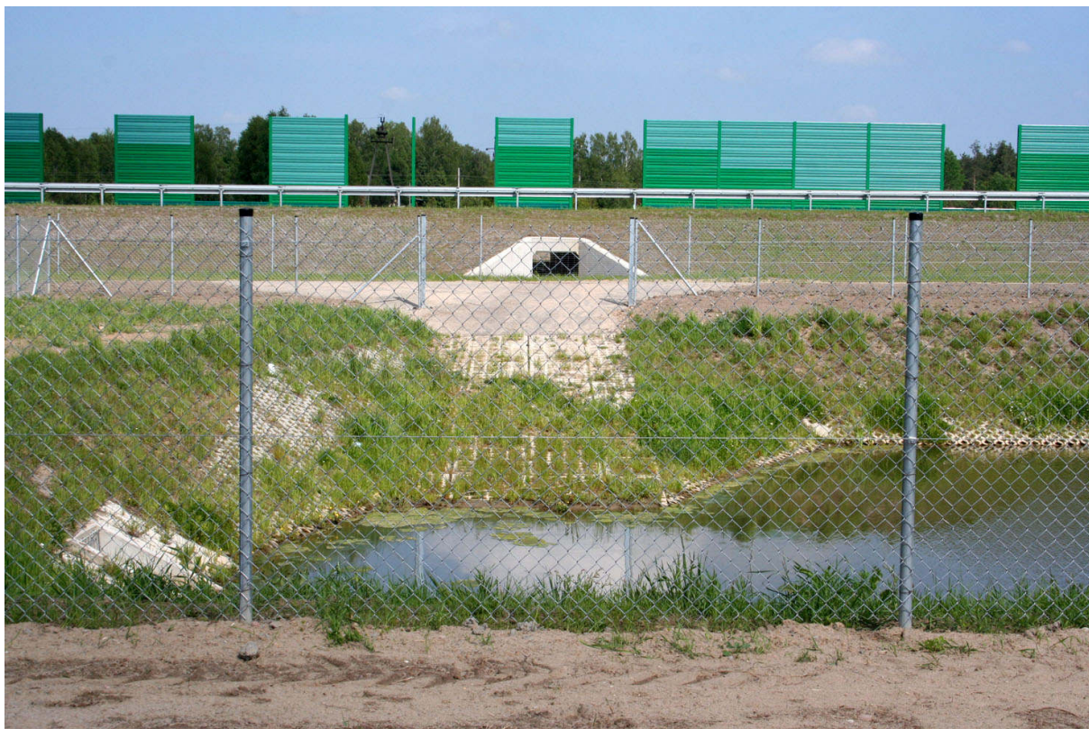
Fot. 28. Przejście dla małych zwierząt z wylotem na ogrodzony zbiornik retencyjny
