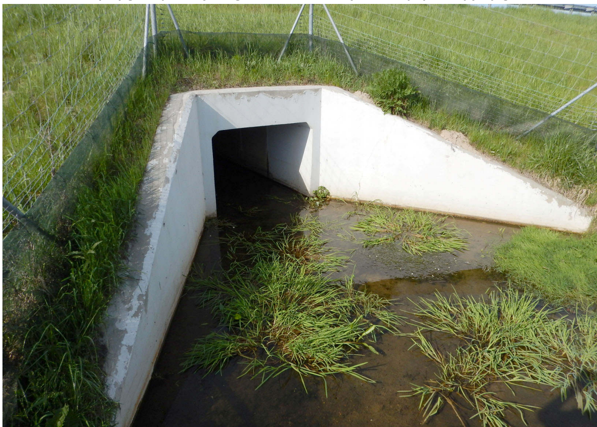
Fot. 23. Trwałe zalanie wodą powoduje, że duża część przepustów nie spełnia funkcji faunistycznych
