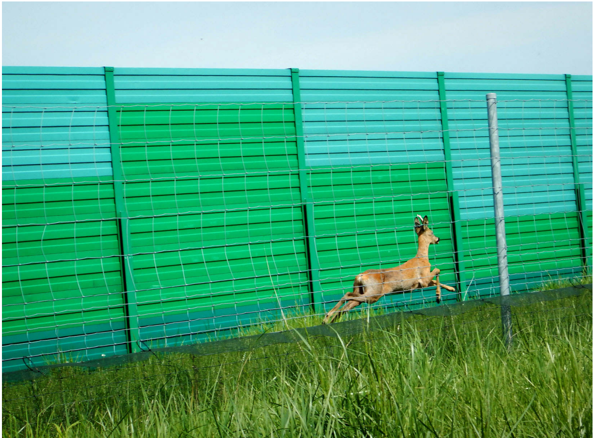
Fot. 11. Sarna po wewnętrznej stronie ogrodzenia – bez problemu przeskakuje ogrodzenie o wysokości 140-150 cm
