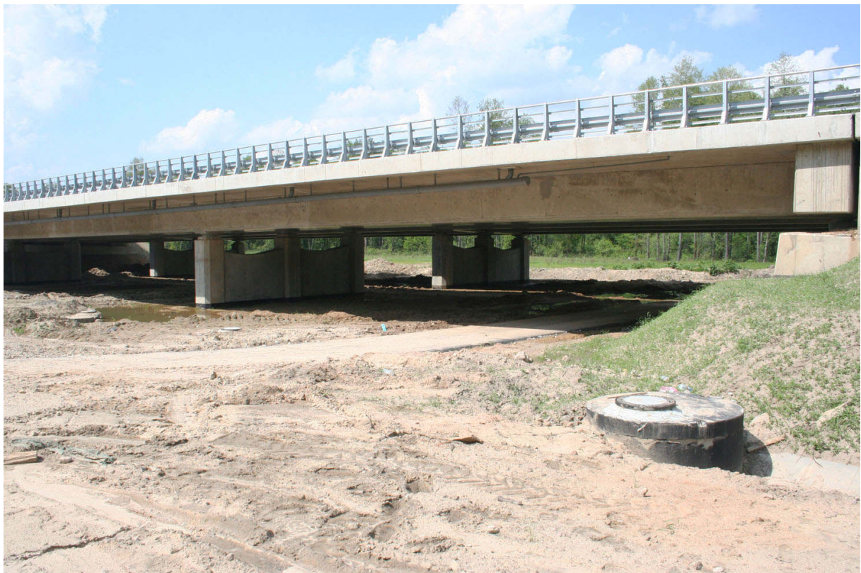
Fot. 5. Dolne przejście dla zwierząt k. miejscowości Jędrzejów Stary-w bezpośrednim otoczeniu znajdują się studnie wpadowe – pułapki dla płazów i małych ssaków
