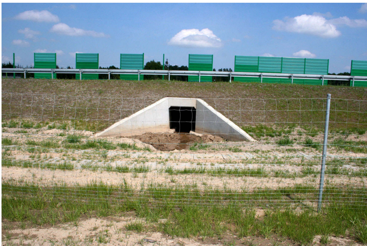
Fot. 29. Przejście dla małych zwierząt całkowicie wygradzone
