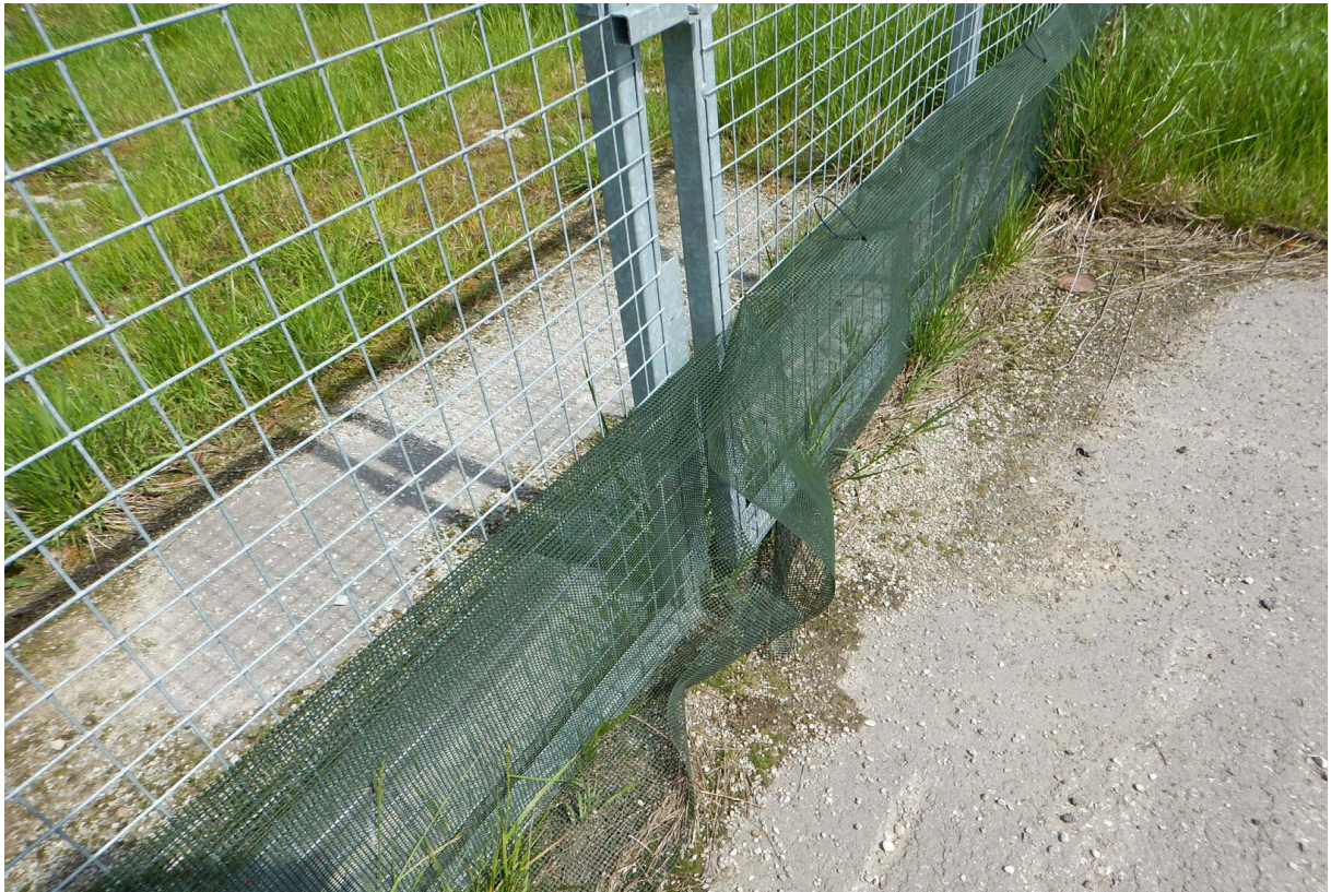
Fot. 14. Przy bramach i furtkach ogrodzenia z siatek polimerowych są nieszczelne-obecne są liczne luki i szczeliny umożliwiające swobodne wychodzenie płazów na jezdnie
