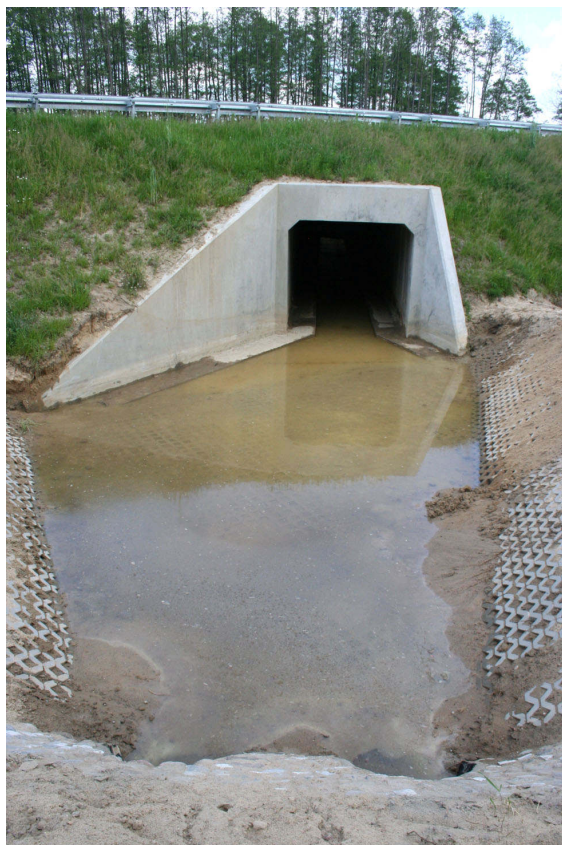
Fot. 32. Przeście dla małych zwierząt z półkami zalanymi wodą
