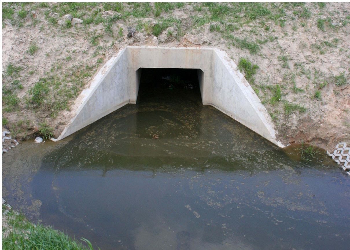
Fot. 33. Przeście dla małych zwierząt z całkowicie zalane wodą
