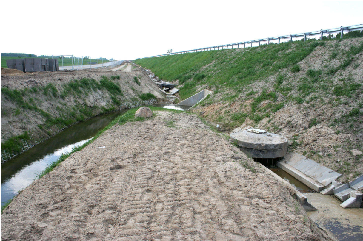
Fot. 36. Studnia wpadowa (pułapka dla płazów i małych ssaków) bezpośrednio przy wylocie przejścia dla zwierząt, dostęp do obiektu dodatkowo blokują głębokie rowy
