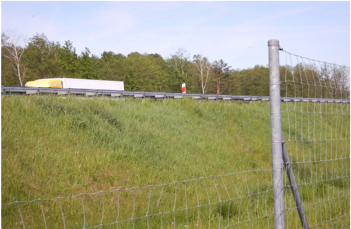
Fot. 10. Ogrodzenie ochronne o zmiennej i dużej różnicy wysokości to błędne rozwiązanie, gdyż ssaki kopytne przemieszczają się wzdłuż ogrodzeń i będą przeskakiwać przy obniżeniach
