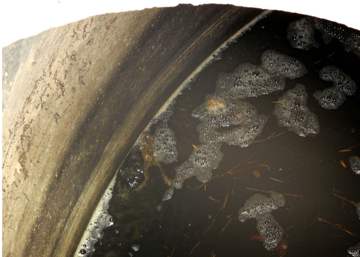
Fot. 35. Płazy uwięzione w studni wpadowej-efekt ich niewłaściwej lokalizacji i braku zabezpieczeń
