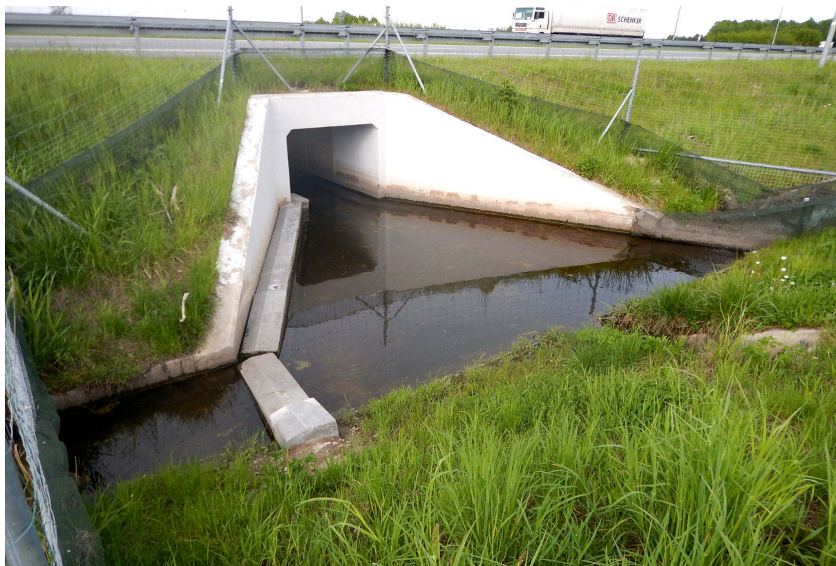
Fot. 24. Prowizoryczna, betonowa półka bez ciągłości w przepłyście
