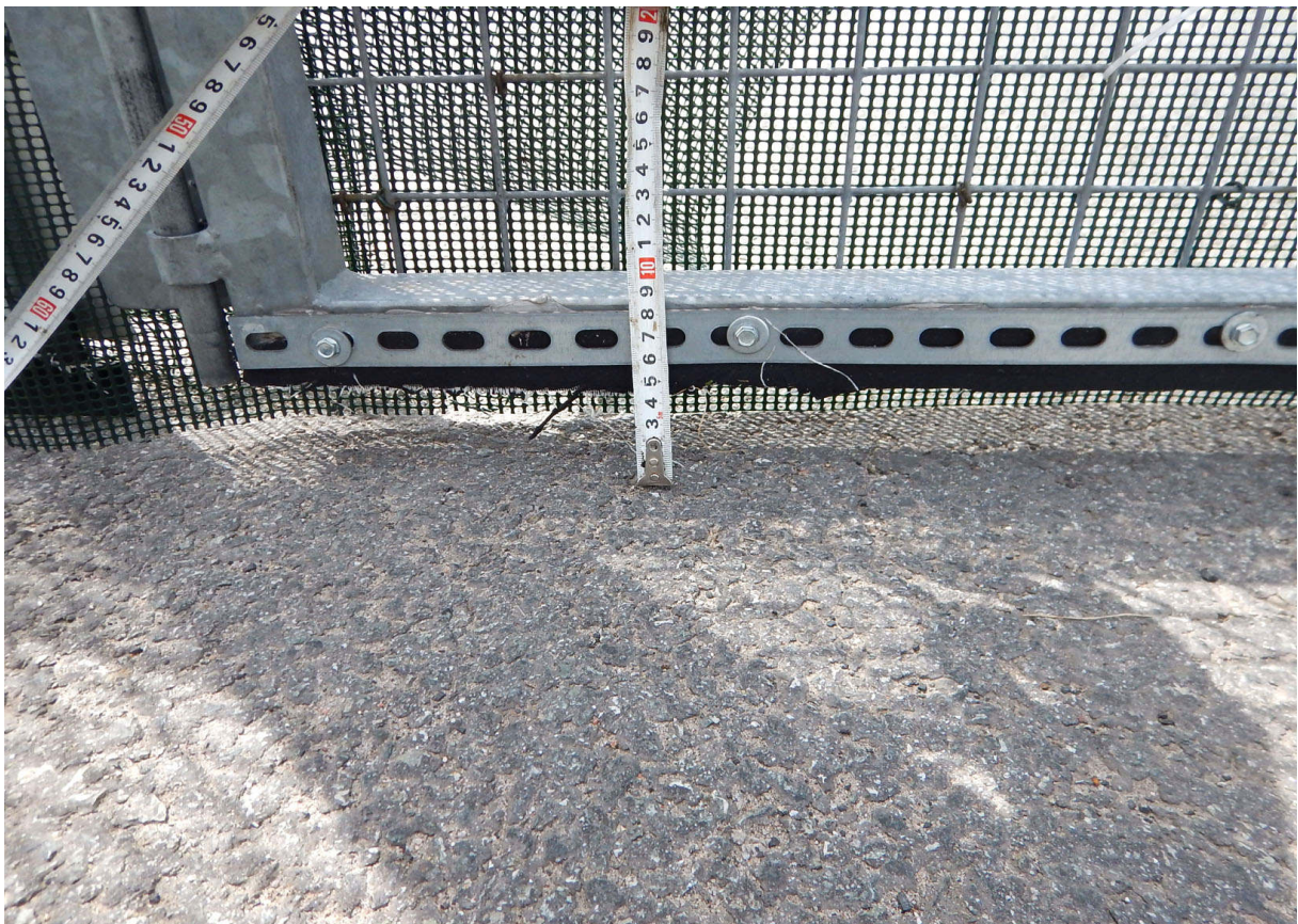
Fot. 13. Dolne krawędzie bram nie zostały odpowiednio zabezpieczone-istniejące szczeliny umożliwiają płazom swobodne wychodzenie na jezdnie
