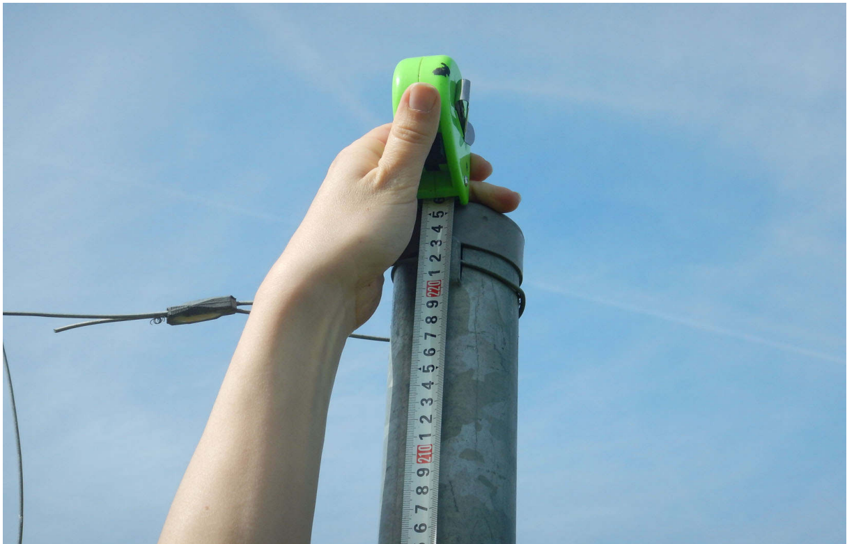
Fot. 9. Ogrodzenie o nominalnej (projektowej) wysokości 225 cm, w praktyce posiada wysokość < 220 cm i także stanowi poważne zagrożenie dla bezpieczeństwa w obszarach aktywności łośia
