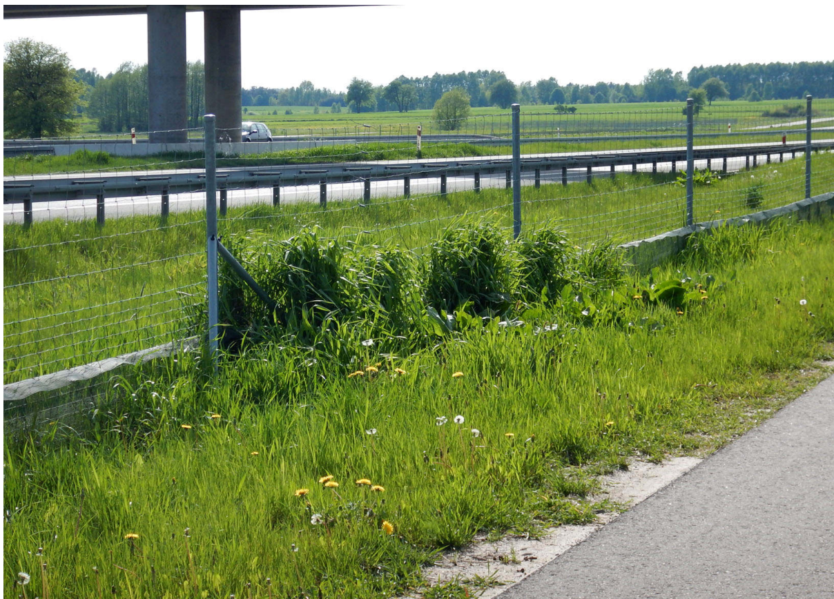
Fot. 21. Brak wykaszania roślinności dodatkowo obniża efektywność ogrodzeń dla małych zwierząt i ułatwia ich przekraczanie płazom
