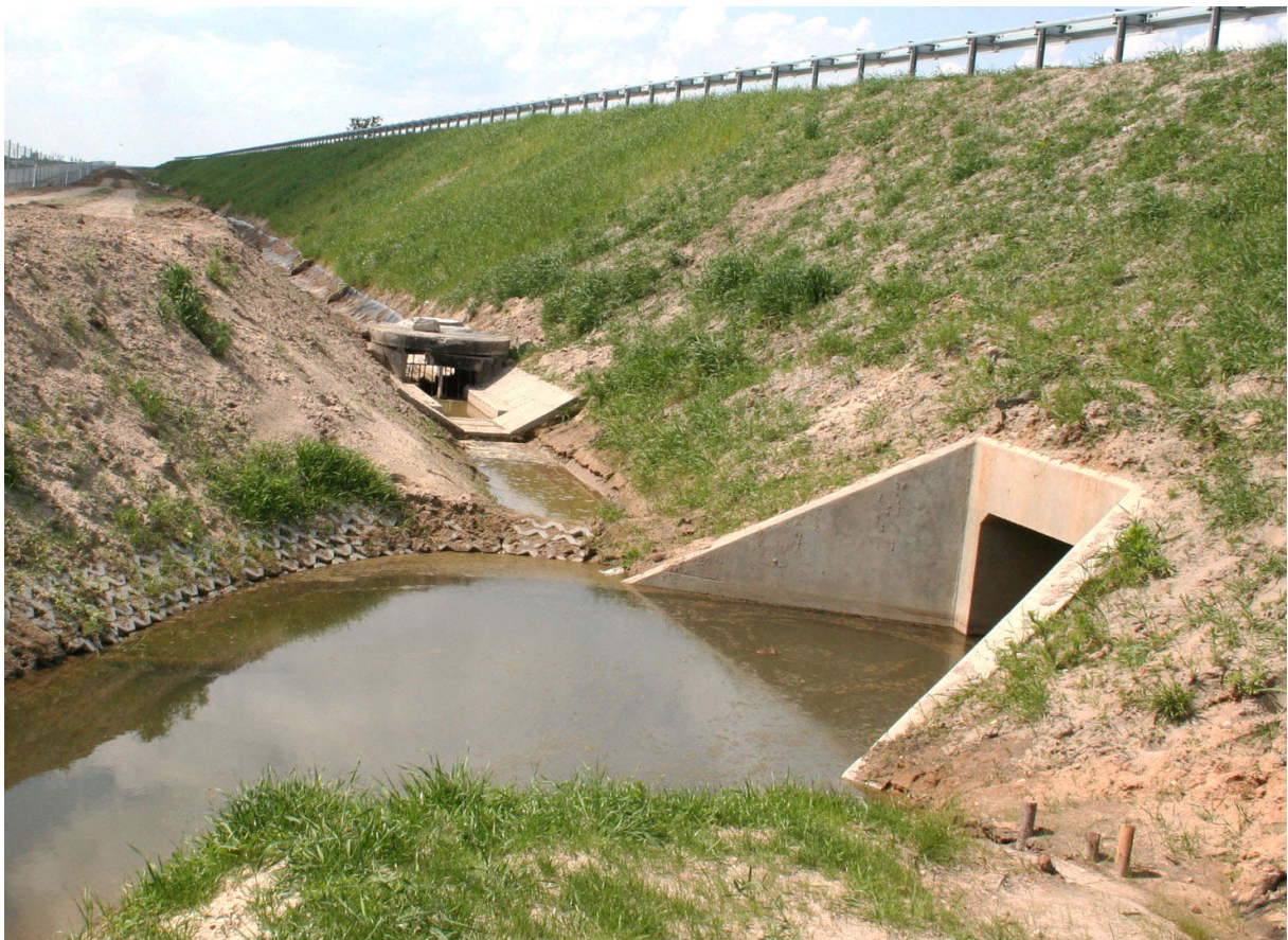
Fot. 37. Studnia wpadowa (pułapka dla płazów i małych ssaków) bezpośrednio przy wylocie przejścia dla zwierząt, przejście całkowicie zalane wodą
