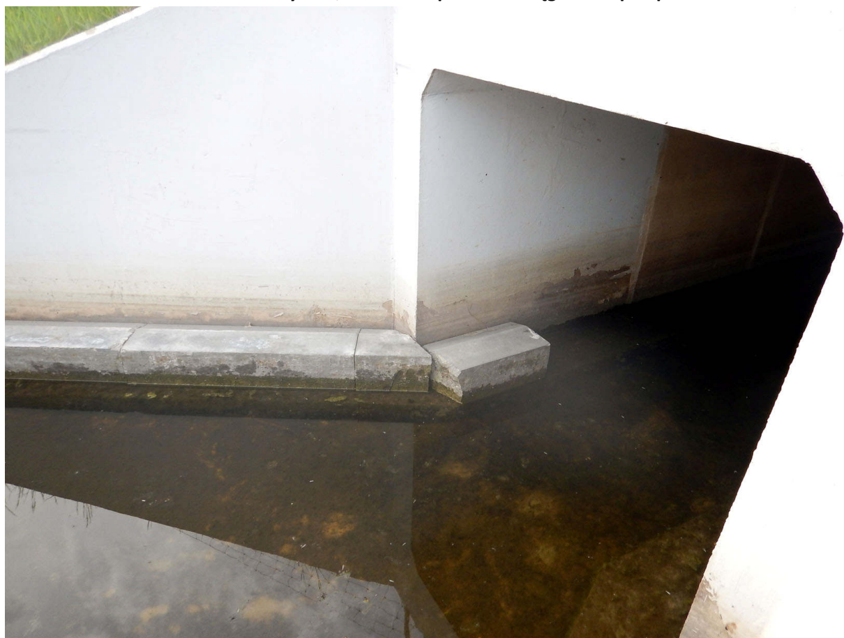
Fot. 25. Prowizoryczna, betonowa półka bez ciągłości w przepłyście
