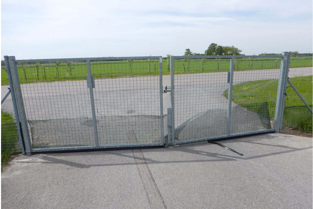
Fot. 12. Nieszczelności przy bramach to poważne zagrożenie dla bezpieczeństwa ruchu-mogą z nich korzystać (w skrajnych przypadkach) nawet sarny i dziki
