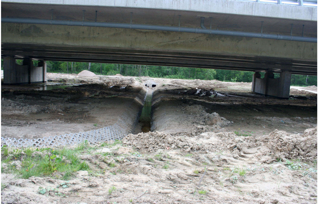
Fot. 6. Dolne przejście dla zwierząt k. miejscowości Jędrzejów Stary-koryto potoku Mienia zostało całkowicie przebudowane z zastosowaniem inwazyjnych umocnień, co utrudnia ruch zwierząt wzdłuż przejścia
