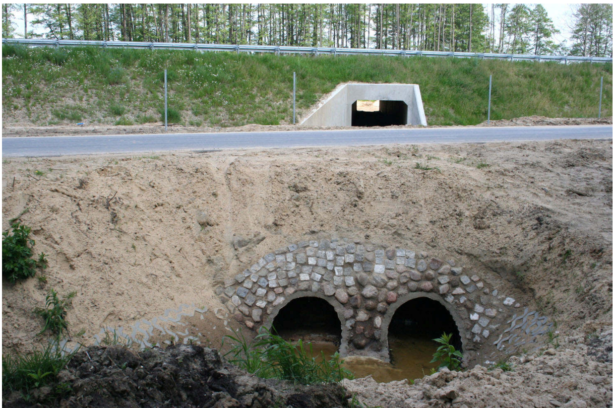
Fot. 31. Przepusty pod drogami serwisowymi nie zostały przystosowane do spełniania funkcji faunistycznych i nie są zsynchronizowane z przejściami pod autostradą
