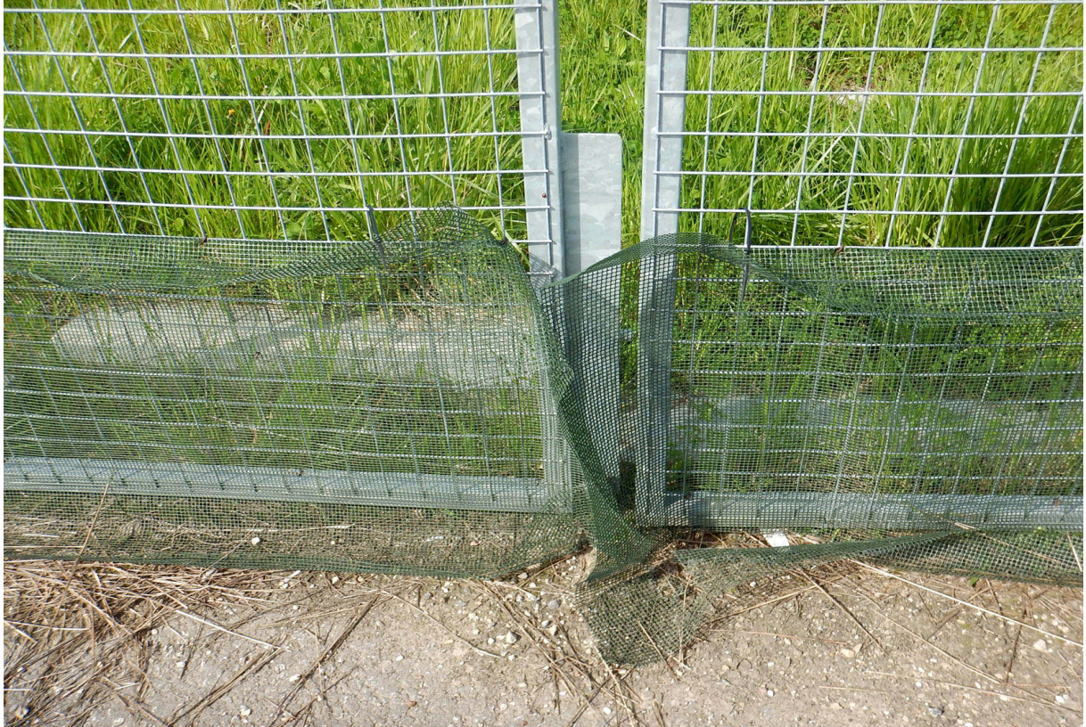
Fot. 16. Przy bramach i furtkach ogrodzenia z siatek polimerowych są nieszczelne-obecne są liczne luki i szczeliny umożliwiające swobodne wychodzenie płazów na jezdnie
