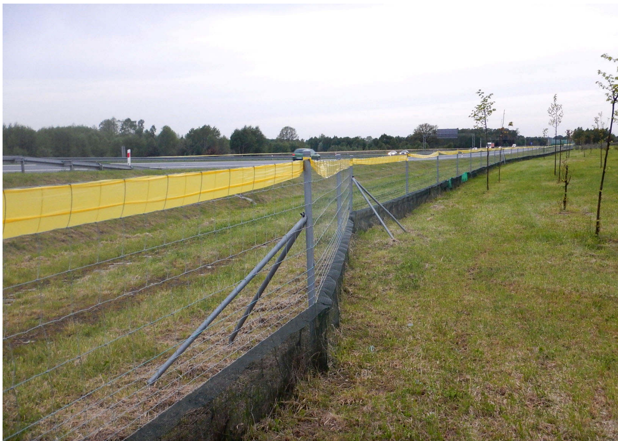
Fot. 22. Taśma przy górnej krawędzi ogrodzenia to rozwiązanie niepoprawiające jego skuteczności
