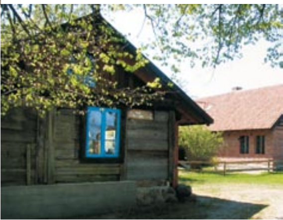
Stary budynek został zachowany jako wiatra i garaż, nowy, z zachowaniem proporcji, powstaje w głębi. Przykład z Mazur
